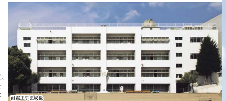
耐震工事完成後
