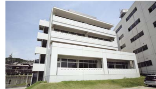
中学校校舎西館 普通教室4教室のほか、加工実習室・制御計測実習室・視聴覚教室などがあります。
